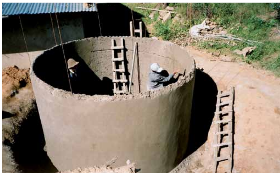
Una cisterna in fase di completamento.
